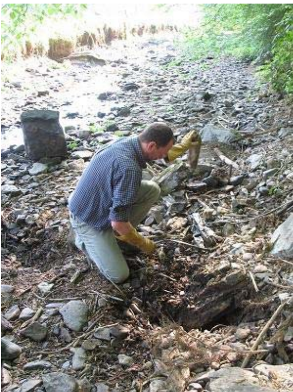
Mario verlegt de eerste blokken aan n° 144
