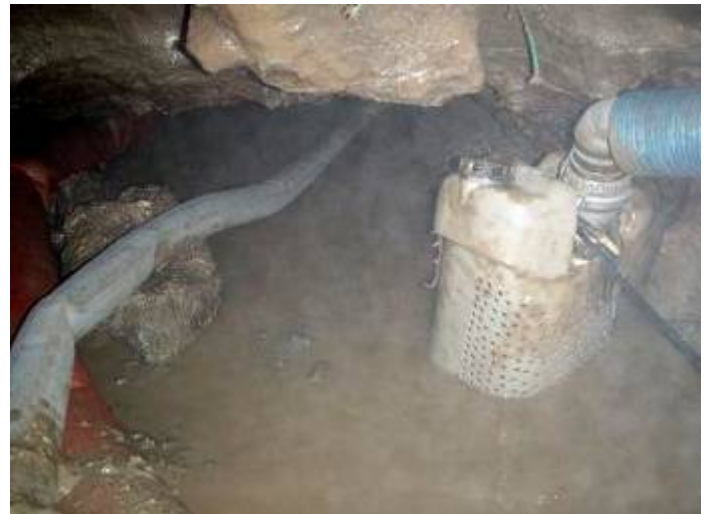
Siphon Moche : Amont kant
